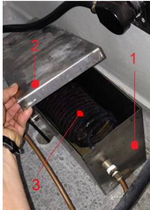
Imagen 2. Tanque de almacenamiento: Autores del trabajo
