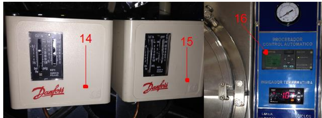
Imagen 10. Presostatos y PLC Fuente: Autores del trabajo
