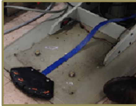
Imagen 20. Cubierta de protección del cableado.
