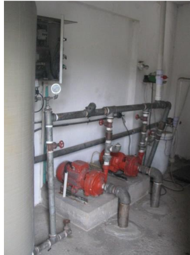
Imagen 37. Cuarto de motobombas
