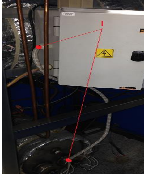
Imagen 11. Cableado de las resistencias
