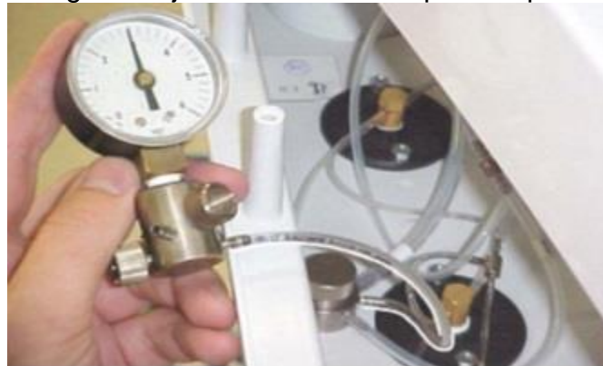
Imagen 13. Conexión de manómetro para medición de presión de depósitos de agua
