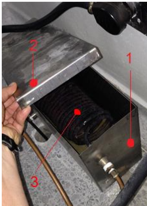
Imagen 1. Tanque de almacenamiento: Autores del trabajo
