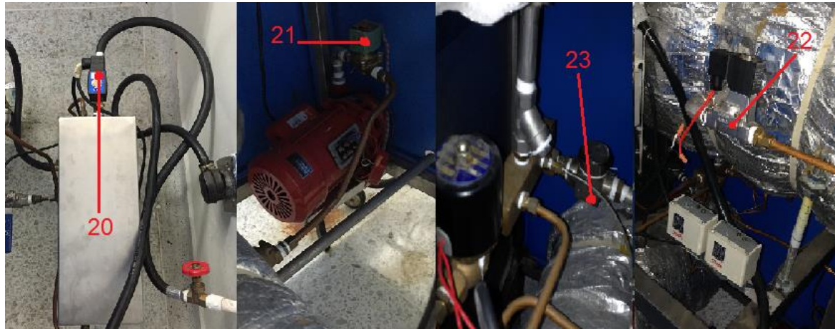
Imagen 8. Actuadores Fuente: Autores del trabajo
