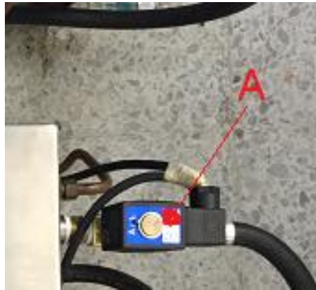
Imagen 4. Electroválvula del tanque
