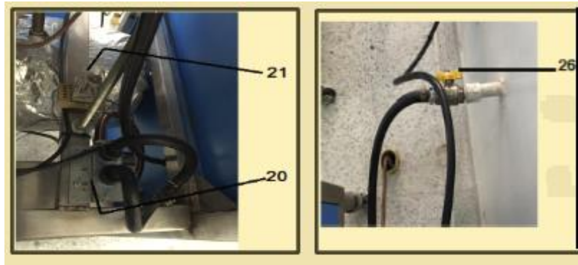
Imagen 2. Elementos asociados al tanque de almacenamiento.
