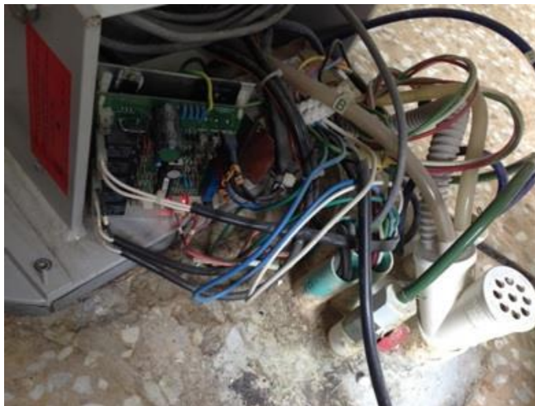
Imagen 8. Etapa de potencia y control
