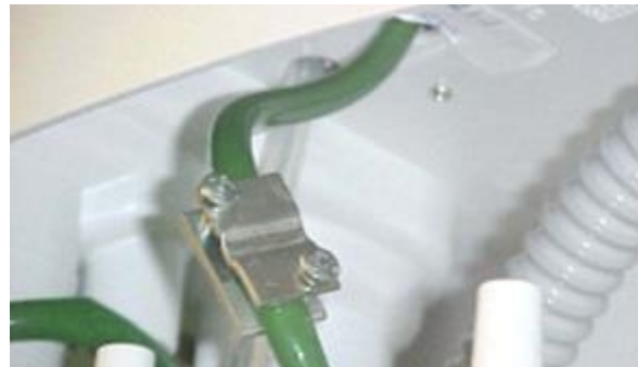
Imagen 15. Manguera y dispositivo de regulación de caudal
