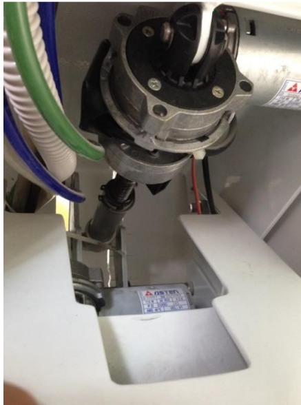
Imagen 23. Sistema sin fin – moto reductor
