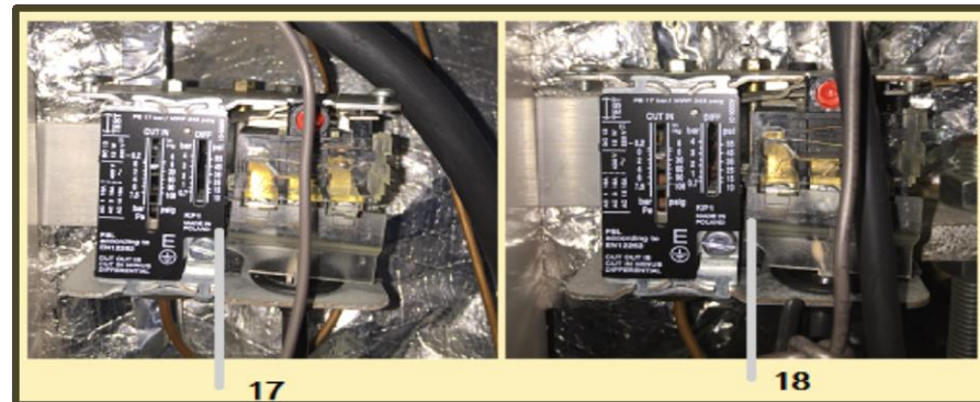
Imagen 9. Presóstatos de carga y descarga
