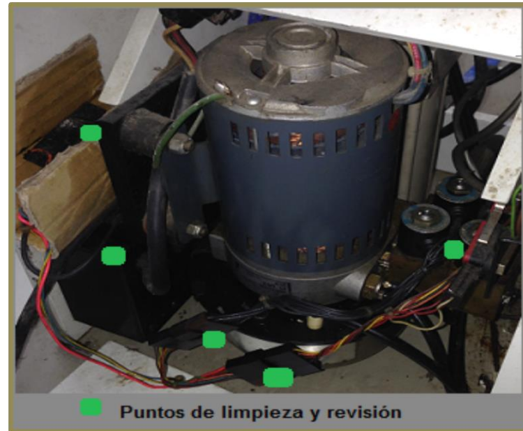
Imagen 24. Acumulación de aceite y terminales de unión múltiples.
