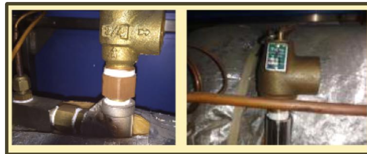
Imagen 7. Válvulas de seguridad de cada autoclave
